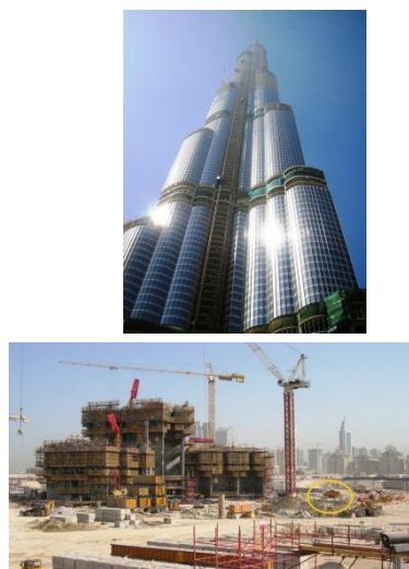
海外のディストリビューターを使用した打設状況 ドバイ バージュハリファ プツマイスターは、高所圧送世界記録603mをこの現場で達成しました。
