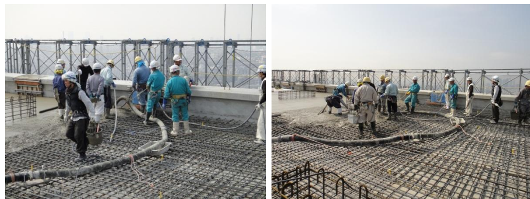
国内: 作業員によるホース曳き廻し作業状況
