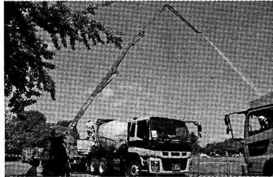
ポンプ車からの放水
