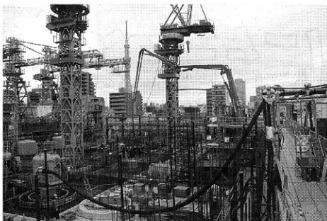
ブームワークで打設を効率化
