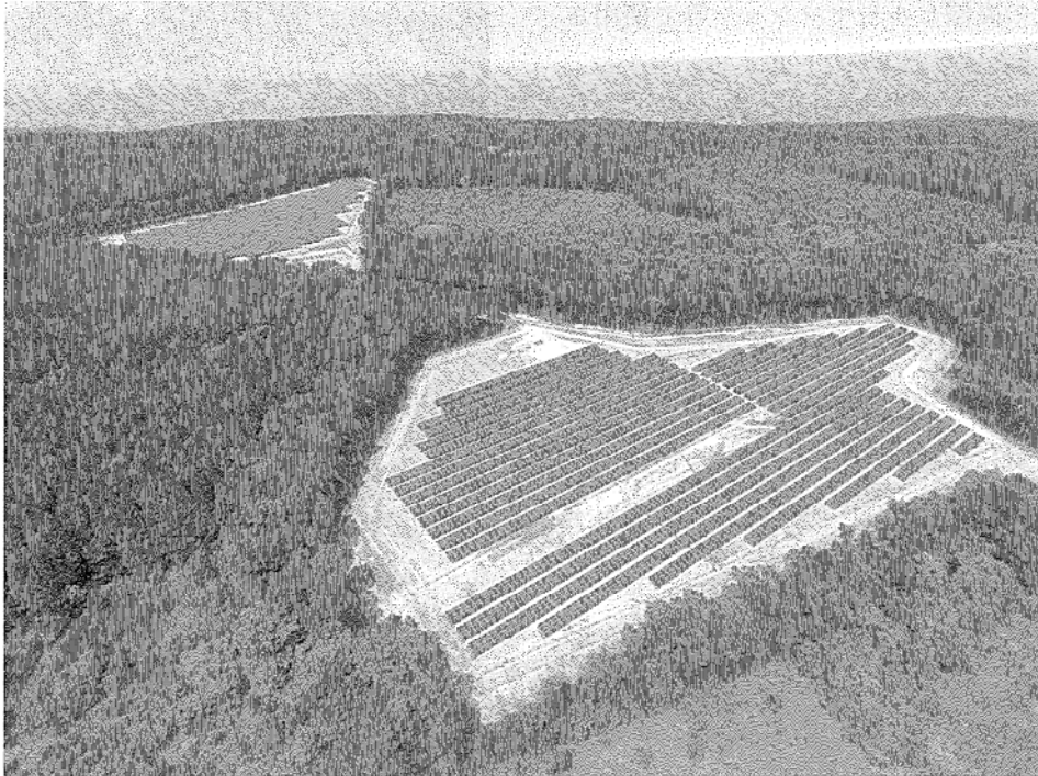
折場沢・北ノ沢の2発電所の空撮写真
