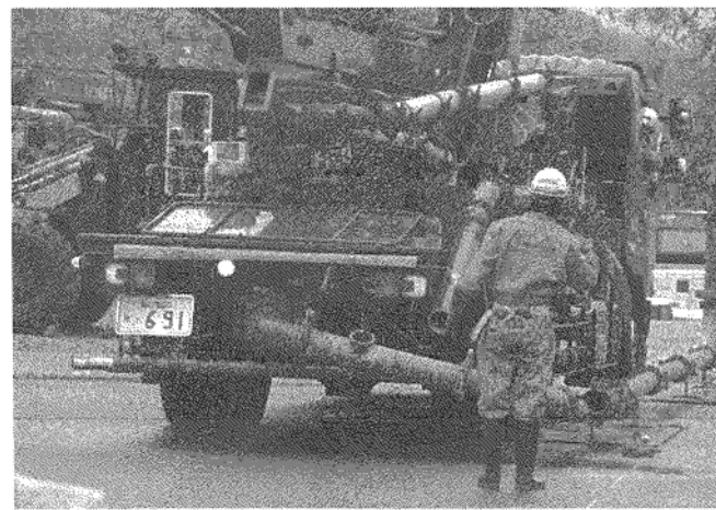
ポンプ車と配管を接続。運転技術も欠かせない
