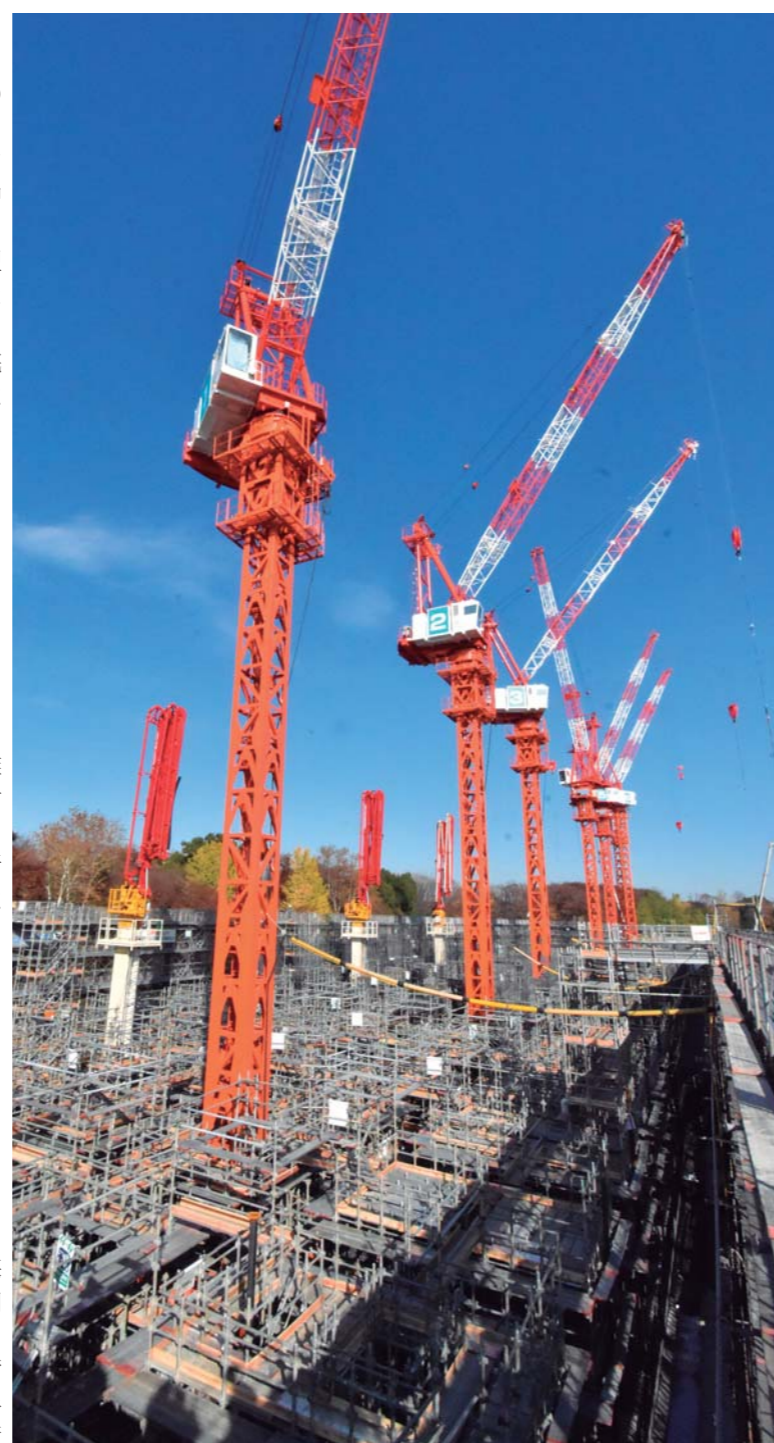
1号ケーソンから2号ケーソン方向に見た現場の様子
